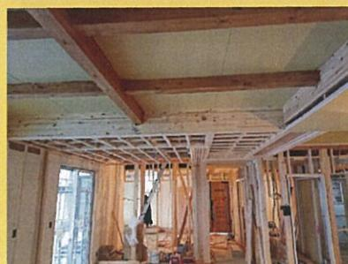
伊那市のM様邸新築工事、引き続き内部造作工事を行なっています。特徴のある三角屋根の形そのままに、内部も天井が張られ、建物の高さを有効的に利用できる小屋裏収納など二階は複雑ですが、大工さんが手際よく作業進めています。ダイニング上には吹き抜けがあり、二階の廊下と空間がつながり、少しつるげるスペースもあって、面白い空間が出来上がりそうです。リビング上部は、化粧で梁が表れ、木のぬくもりを感じます。大工さんの造作工事も終盤です。3月の完成が楽しみです。
