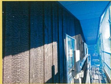
宮田村のK様邸新築工事、内部仕上げ工事行っています。外壁の上部には焼杉を張りました。焼杉とジョリバットの塗り壁、金属サイディングの張り分けをしていますが、それぞれに趣きがあって、存在感が増します。内部は床には無垢の赤松材を張り、壁には珪藻土を塗っています。お施主様に、ワンポイントでキッチンの腰壁部分を塗っていただきました。12月中に完成し、1月には完成見学会を予定しています。まもなく完成します。完成見学会、是非ともご来場ください。
