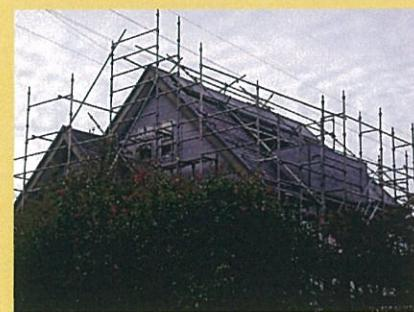
駒ヶ根市のO様邸改修工事、外壁の張替えと屋根の塗替えを行なっています。外壁周りの他にユニットバスへの入れ替えとトイレの水洗化を行ないます。外壁の張替えと屋根の塗替えには足場を組みます。屋根は勾配が急なため、屋根足場を組んで転落を防止します。外壁は光触媒で汚れが付きにくい窓業系サイディングに張り替え、屋根も新しい色に塗り替えられます。外観の雰囲気はまったく新しく生まれ変わります。仕上がりが楽しみです。
