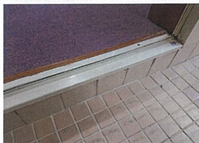
↑改修前 浴室入口の段差解消 ↓改修後
