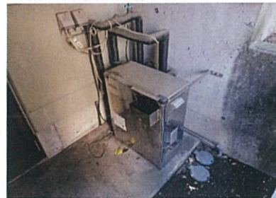
↑改修前 高効率給湯器への取替 ↓改修後
