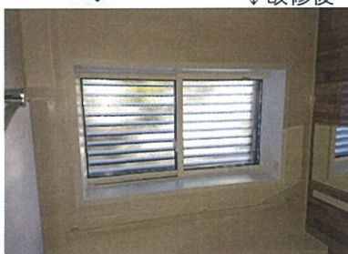
↑改修前 断熱外窓への交換 ↓改修後
