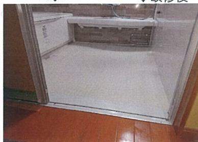
↑改修前 浴室入口の段差解消 ↓改修後
