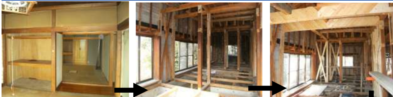
① 解体前の既存居間と奥の和室 ② 柱を残して内部解体した状況 ③ 柱を撤去し、梁を補強
