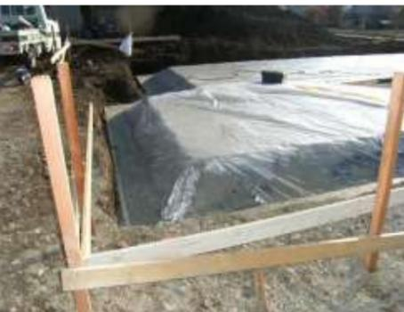
伊那市のO様邸、基礎工事に入りました。10月より、造成、地盤改良、擁壁工事を行い、11月よりいよいよ基礎工事、12月に建て方予定です。傾斜だった土地を造成し、新しい住宅を建てます。無垢の木と漆喰で建てる「雨楽な家」です。O様邸にも薪ストーブが入ります。最近、ほとんどの住宅で薪ストーブが採用されています。新しい住まい、3月完成です。楽しみです。←写真は、ベタ基礎下の成形状況です。
