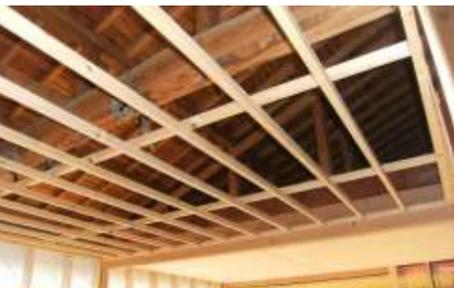
宮田村のK様邸、内部の造作工事真っ最中です。内部の大規模リフォームを行っています。南面は3室あった部屋が、一つの大きなリビングダイニングキッチンへ生まれ変わります。一部柱を抜くので、大きな梁で補強を行います。補強の梁を化粧で露出をさせ、天井を掘りこんで、なるべく高い天井を作ります。新しい住まいで新年を迎えるべく、12月中旬完成予定です。
