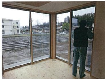
伊那市のA様邸新築工事が無事完成し、お引渡しと住宅設備類の取扱説明をさせていただきました。取扱説明書もお渡ししますが、とても厚いファイルになります。そのため、給湯器(エコキュート)や暖房設備の説明を設備業者さんやメーカーの担当者の方にお願ひします。A様のお宅にはノーリツの暖房設備があります。室外機から温水を室内に循環させるヒーターとパネルヒーター、温風ヒーター、エアコンとフル装備です。当日は肌寒い日でしたが、ヒーターの近くは輻射熱でとても暖かく、幸せな空間でした。リビングのサッシはトリプルガラスで、ガラスの窓面に顔を近づけても冷気を感じません。隙間風もなく気密性も抜群です。とても温かそうな新しい住宅が完成しました。ありがとうございます。
