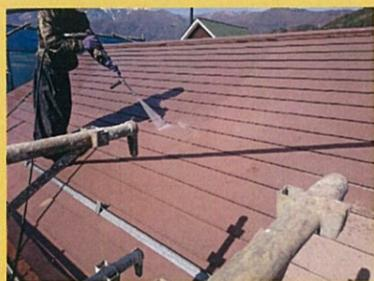
伊那市のY様邸屋根及び外壁塗替え工事行いました。築20年ほどの住宅の外回りの塗替えです。工事はおおむね二週間。まずは家の周りに足場を組みます(一日目)。次は水での高圧洗浄、汚れなどを洗い流します(二日目)。屋根は、板葺きなので、サビ止め塗装を施してから、仕上げ塗を行ないます(ここでおおむね一週間終了)。外壁を二回塗って、樋、幕板の金属部分を塗って、塗装完了。足場を外して工事完了です。きれいな家に生まれ変わりました。
