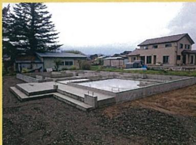
駒ヶ根市のO様邸新築住宅、基礎工事完了しました。基礎は建物を支える重要な役割を持っています。昔は土台下部分のみにT字形の基礎が回っていただけでしたが、今は建物の下にはべたで基礎を打って、建物の力を全面で伝え持つ役割となっています。合わせて下からの湿気もシャットアウト。白アリさんも降参です。給排水管も位置を合わせて基礎工事と並行して配管をします。次はいよいよ建て方。家の姿が浮かび上がります。
