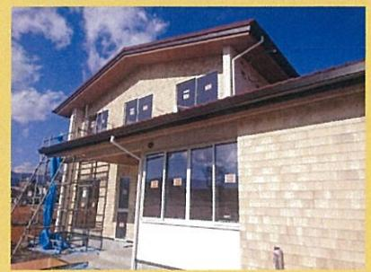
南箕輪村のA様邸新築工事、造作工事完了しました。外部も外壁が張り終わり、足場も撤去されました。玄関正面周りの外壁の仕上がりは、木のサイディングとジョリパット。凹凸を感じる仕上がりは、重厚感もあり落ち着いた空間を演出しています。内部はクロス工事に入っています。壁のつなぎ目をパテで処理してオガファーザーを貼ります。トリプルガラスのサッシの断熱効果も期待できそうです。3月末の完成予定です。完成が楽しみです。
