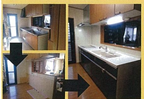
箕輪町のM様邸のキッチン取替工事完了しました。約15年前のシステムキッチンの撤去新設工事を2日間で行いました。1日目、キッチン撤去して、給排水給湯の配管の布設替えをして、既存のキッチンパネルをクリーニング業者さんにきれいに磨いてもらい終了。2日目、新しいキッチンを設置、午後には給排水給湯を接続して、通水試験、取扱説明をして工事は完了となります。既存の吊戸棚は残しましたが、スライド型の収納にしたので、収納力もアップ。お手入れラクラクのレンジフードは、奥様の掃除が格段に楽になりました。天板も白い人造大理石で明るく清潔なキッチンに生まれ変わりました。
