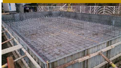
基礎工事の様子
