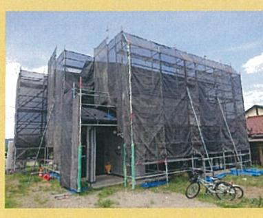
駒ヶ根市のH様邸外壁他塗装工事、着手しました。14年前に建てられた住宅の屋根と外壁の塗替え、コーキングの打ち替えと、ベランダの防水施工を行ないます。屋根にはフッ素塗装を、外壁にはシリコン塗装を計画しています。ベランダ部分は漏水が見られ、一部床が沈むところもあるので、床の下地を大工さんになおしてもらつてからの防水施工を予定しています。外部に足場を組んで、作業転落と飛散防止用のメッシュシートを張ります。工期はおおよそ3週間。完成が楽しみです。
