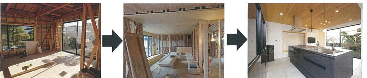
左写真:改修中の状況です。外壁周りのサッシは全て断熱窓に取替えました。LDKは、高さのあるハイサッシ(H=2.2m)としたので、日差しも家の奥まで入り込み、明るい空間となりました。
