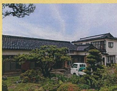
伊那市のT様邸新築工事、既存建物の解体を開始しました。T様のお宅は、既存建物を解体した跡地に新しい住宅を建てます。大きな母屋の平屋部分は解体し、奥の二階建て部分は離れとして活用するため、残します。玄関先の古木は立派な梅の木のため、この木を玄関先に配して、間取りの計画をしました。解体を行ない、地盤調査をして、いよいよ住宅の着工となります。新築住宅は平屋となります。完成は年内を計画しています。
