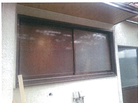
浴室外部(壊さない外窓状況)
