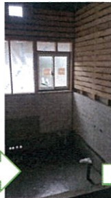
②土間コン打設
