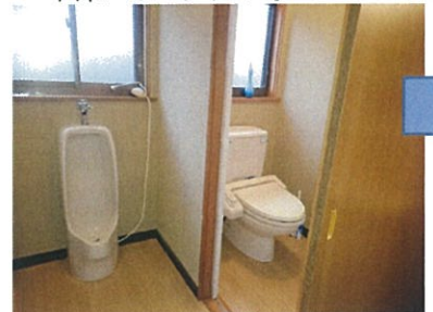
↑トイレ改修前
