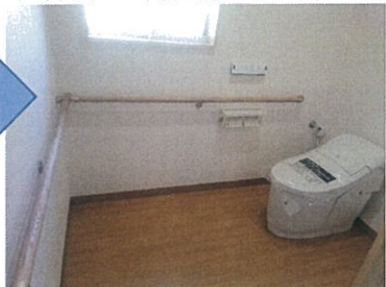
↑トイレ改修後
