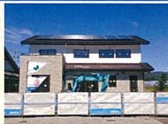
駒ヶ根市のM様邸、足場もはずれ外観が登場しました。内部は造作工事もほぼ完了、仕上げ工事に入ります。外壁は白をベースに、1階の正面部分は石模様のサイディングを張って重厚感を演出しています。屋根にはソーラーパネルを搭載。発電も開始しています。完成まもなくです。
