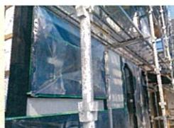
駒ヶ根市のY様邸、外壁工事真っ只中。増築部分の外壁も母屋と同様に東面は塗り壁で仕上げています。左官さんの手仕事で、きれいに壁が塗られています。腰壁には下見板が張られて、落ち着いた黒色で塗装を施しています。足場の外れるのが楽しみです。こちらもまもなく完成します。
