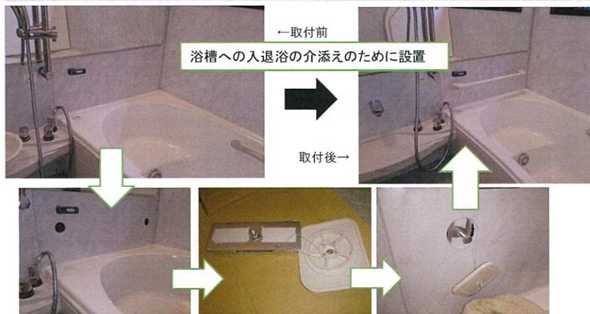
ユニットバスへの手すりの設置は、後施工となるとメーカーの下地専用金物を用いて取りつける必要があります。
