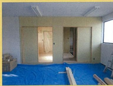
駒ヶ根市のH様邸下水道工事、内部改修を行なっています。H様のお父様の会社の機器関係の展示をしている建物の水廻りを改修し、敷地内の下水道も新設します。まだ寒いので、外部の下水道工事は3月から行なうこととして、まずは内部の水廻り工事を先行して行います。間取りを一部変更して、ユニットバスの新設、トイレの水洗化、キッチンのリフォームを行なっています。3月中旬には工事完成予定です。完成が楽しみです。
