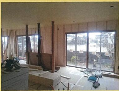
宮田村のK様邸改修工事、造作作業行っています。解体してから、内部の間取り変更に伴う下地組、補強工事を行ない、床の下地を組みました。外部をブルーシートで仮囲いしていましたが、サッシも付き、シートを撤去して、外の景色が家の中に入ってきました。広いリビングダイニングキッチン空間に、南面の大きな窓から光が燦々と差し込んできます。部屋の間仕切り壁もどんと出来上がり、空間も分かるようになって来ました。完成が楽しみです。
