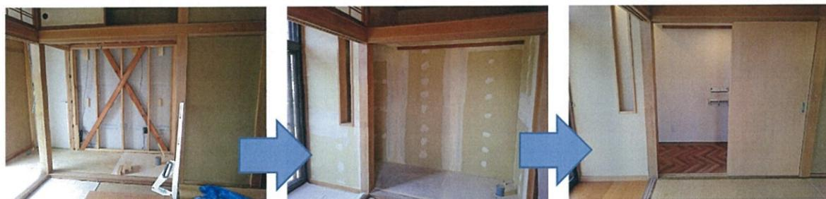
妻の実家のリフォーム工事をご紹介します。メインのトイレとは別に、お父さんの寝室の一角に小さなトイレがありました。お父さんは訳があって、トイレがちかく、器具を洗浄するスペースが必要で、元々のトイレでは少し不具合を感じていました。そこで寝室の押入れと縁側の一部をトイレに、元のトイレを物入れに入れ替えるリフォームをしました。まずは押入れの床をめくって床下の給排水管を新設、押入れと縁側の壁を壊して、1帖半のトイレスペースを確保しました。元々の押入れのふすまは木製の戸に替えて、いざとなったらすべて取り外してカーテンで仕切れるようにあえて壁をつくりませんでした。押入れの上の天袋はそのままにしたので、トイレの天井は少し低いですが、用を足すには問題ありません。お父さんにも大変喜んでもらって、使いやすいトイレが完成しました。ありがとうございました。
