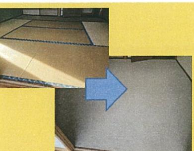
駒ヶ根市のM様邸和室改修工事、完了しました。和室の一室のタタミを撤去してカーペットに張り替え、京壁を落としてクロスに張り替えました。畳は撤去して、大工さんに根太を入れ断熱材を敷き込んで下地を作つもらいます。その後、内装屋さんに京壁の表面を削り落し、パテを全面に施して、クロスを貼り、最後にカーペットを敷き込んで終了となります。カーペットはフカフカであたたかく、M様にも喜んでいただきました。階段にも手すりをつけて、工事完了。ありがとうございました。
