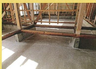
宮田村のK様邸改修工事、解体が終了し内部造作工事を行っています。床を解体し、土間にコンクリートを打ちました。床には土台と根太を新しく組み、そこに断熱材を敷き込みます。内部の空間も一部変わりますが、床が組み上がると、新しい間取りがイメージすることが出来ます。ここからは、外回りのサッシを取り外し、新しい断熱窓を取付ける作業に進みます。新しい窓になるとより一層空間が変わって見えると思います。これから寒さも厳しくなりますが、大工さん宜しくお願い致します。
