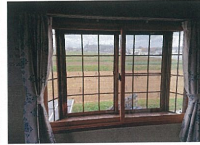
↑改修前 断熱内窓の新規設置 ↓改修後
