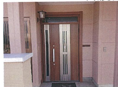
↑改修前 断熱玄関ドアの取替 ↓改修後
