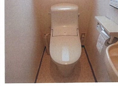
↑改修前 節水トイレの取替 ↓改修後
