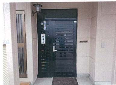
↑改修前 断熱玄関ドアの取替 ↓改修後
