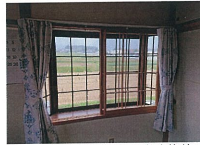
↑改修前 断熱内窓の新規設置 ↓改修後
