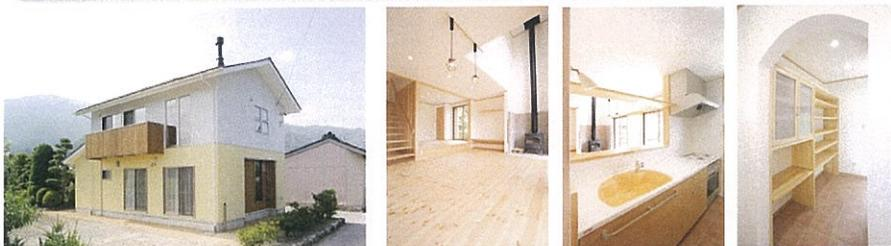
K様こだわり満載の住まいが完成しました。外観は雨染な家仕様。玄関などにポイントで木の羽目板を張りました。内部は、床はパインの無垢材を張り、1階の壁は珪藻土の塗り壁としました。吹き抜けを設けることで、薪ストーブのぬくもりが家中に広がります。システムキッチンの上にはグラスハンガーを取付ける棚板を設置。食器棚類は造り付けでパントリー内に納めました。お施主様の使いやすいすっきりしたキッチンが完成です。ちなみに床は300角のタイルを貼っています。リビングの横には小上がりのタタミスペースがあり、玄関から部屋に入ると、スケルトン階段越しに見ることができます。洗面化粧台も手作り、既成の化粧台のカウンター部分のみ取り外し棚板にはめ込みました。化粧台横には収納棚も造作。家を建てながらお施主様と打ち合わせしながら作りこんだ住まいの完成です。
